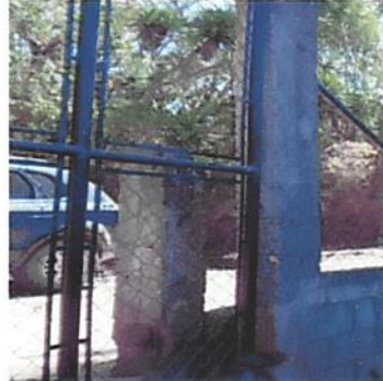
Foto 4: se realizara la reparacion y cierre de dos portones
