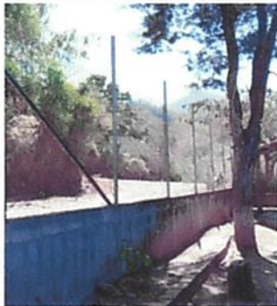
Foto 5: Seguimiento muro perimetral
