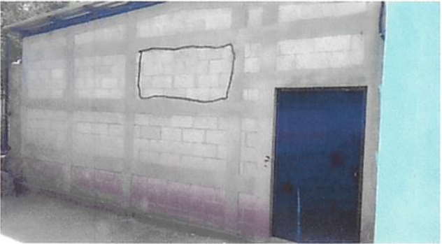
Foto 3: Se fabricaran e instalaran Ventana
