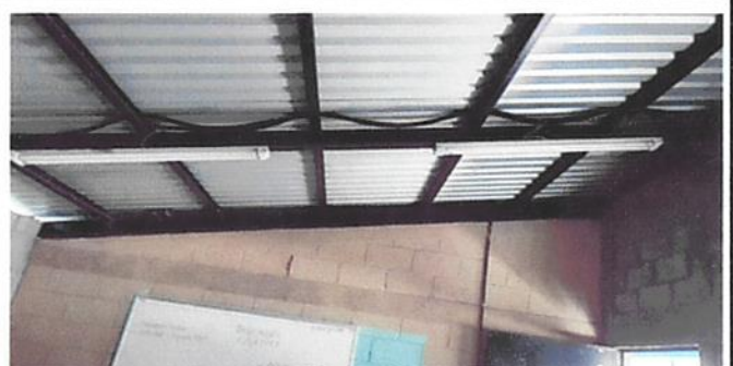
Foto 6: (Reparacion de sistema electrico
